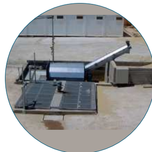
Concrete tank - recycled water Réservoir en béton - l'eau recyclé
